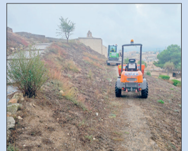
Comencen les obres del Pla de Santa Bàrbara
